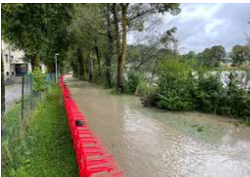
DER MOBILE HOCHWASSERSCHUTZ schützte die dahinterliegenden Bereiche in der Münchner Straße. Fotos: Feuerwehr Kufstein
