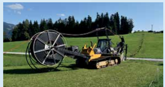
Mit Spezialgeräten wie dem Kabelpflug konnten auch entlegene Gebiete mit Breitbandinternet versorgt werden.
