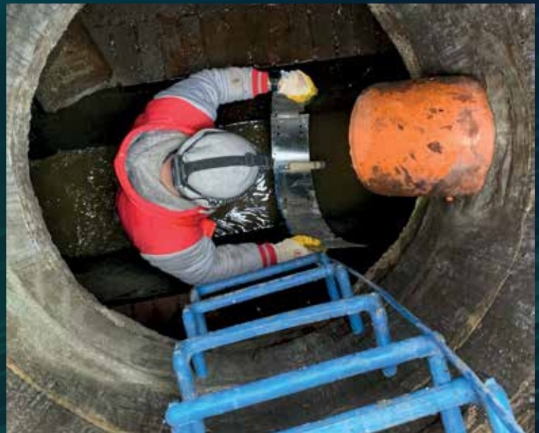
Über die Kanalschächte wurden die Online-Messstationen installiert.
