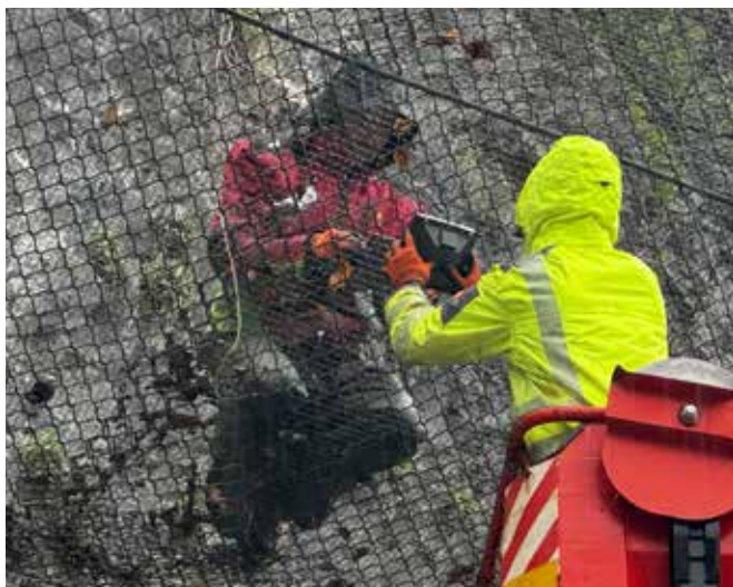
Am 10. April wurden KI-Sensoren im Steinschlagnetz der Festung montiert. Fotos: GMD, Steve Weingarth
