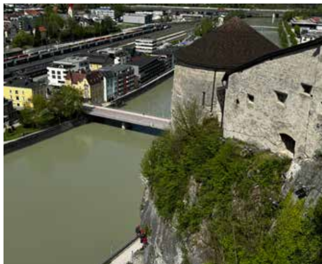
Industriekletterer befestigten Sensoren an der Felswand der Festung Kufstein, um seismische Aktivität zu messen.
