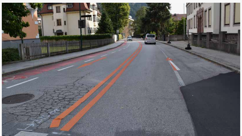
Die Verkehrsführung im Gegenverkehr in der Schillerstraße.
