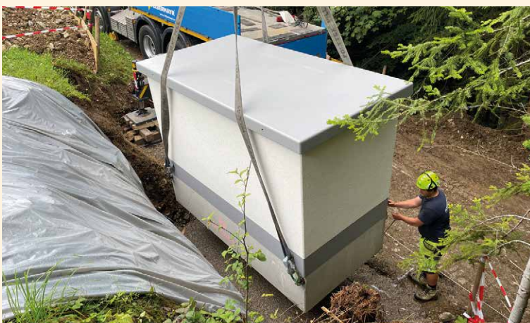
Im Glemmtal wurden zwei neue Trafostationen errichtet.
